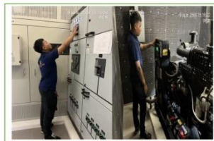
ช่างอาคาร PM ตู้ MDB (Main Distribution Board) เครื่องกำเนิดไฟฟ้า (Generator)
