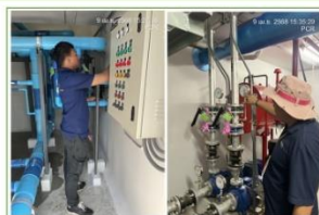
ช่างอาคาร PM ระบบสระว่ายน้ำ ( SWIMMING POOL SYSTEM ) บั๊มน้ำดี (Transfer Pump)
