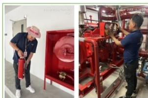
ช่างอาคาร PM บั๊มน้ำดับเพลิง (Fire Pump Engine) ตู้ดับเพลิง (Fire Hose Cabinet)
